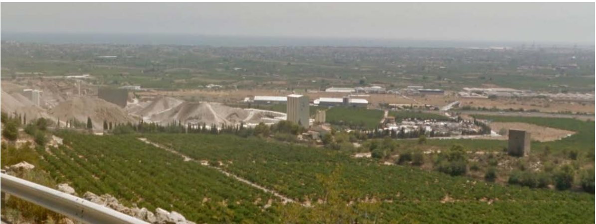
Vista desde el Castellet, con la Cantera y la Torre Alonso en primer plano (1300 m)
