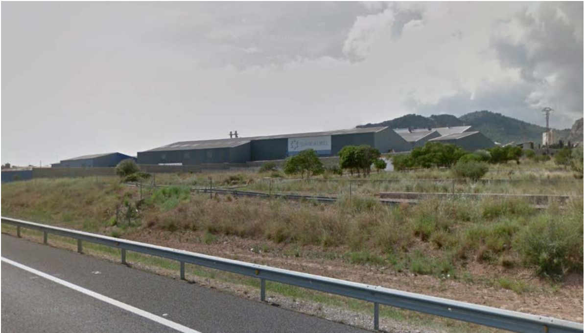
Vista desde la AP-7 / Cuadra Colomer , sentido sur.
