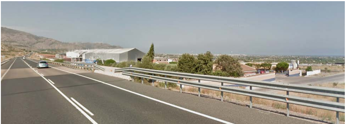
Vista desde la CN-340, sentido norte.
