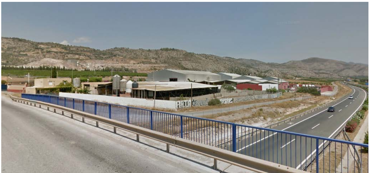
Vista desde Camino Romeral, sentido este.
